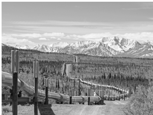
图 2-8 部分阿拉斯加原油管道在地面上架空修建
